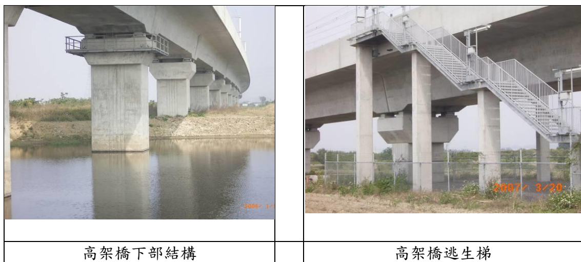
圖 2-3 高鐵高架橋段完工實景
